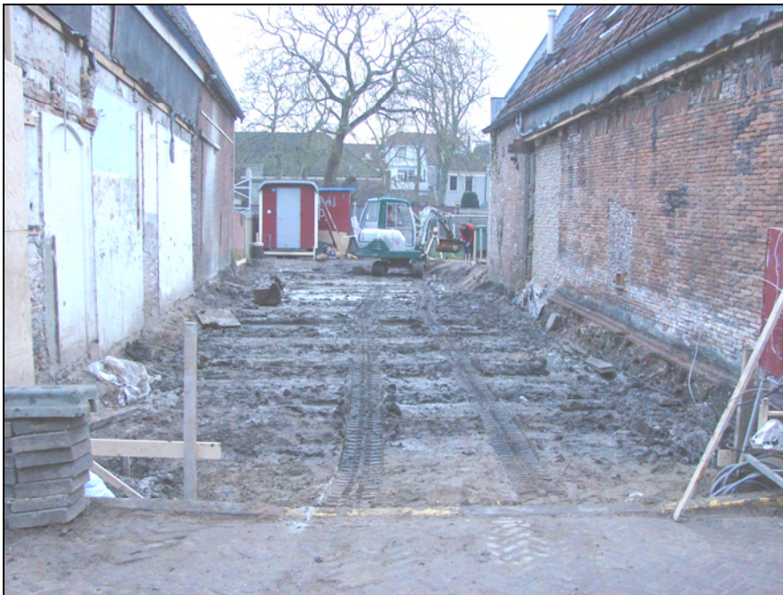
Afbeelding 7: overzicht van de onderzoekslocatie bij aanvang van de werkzaamheden. Foto noordoostwaarts genomen.
